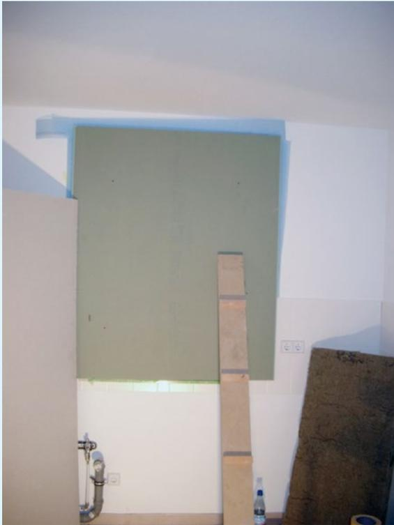
Abbildung 1: Verkleidung Fenster innenseitig mit biegeweicher Vorsatzschale
